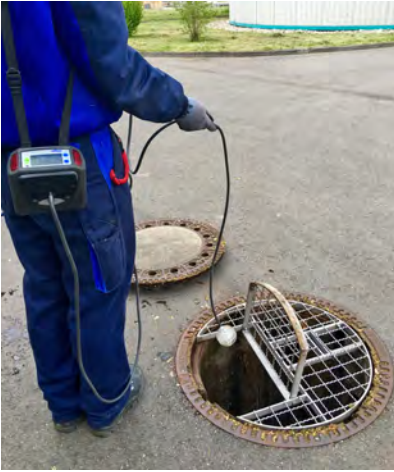
Abb. 2: Auf die Arbeitssicherheit beim Freimessen achten
