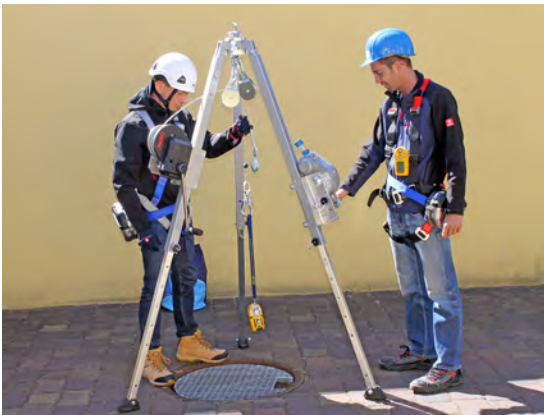
Abb. 2: Freimessen eines Schachts
